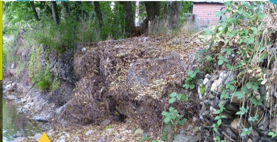
Les gabions formant le mur de soutènement étaient en très mauvais état : pour la plupart éventrés et évidés ou renversés dans le cours d'eau. De ce fait, ils ne remplissaient plus leur rôle.
