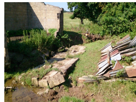
Ouvrage à Toernich
