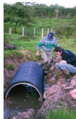
Placement d'un demi-tube en PEHD
