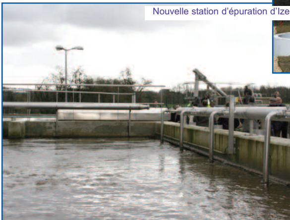
Nouvelle station d'épuration d'Izel
