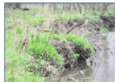
Erosion à Straimont (Herbeumont) le long de la Vierre.
