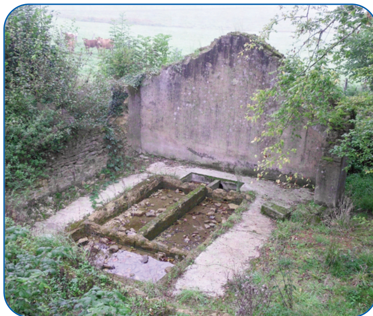
Lavoir avant travaux.
