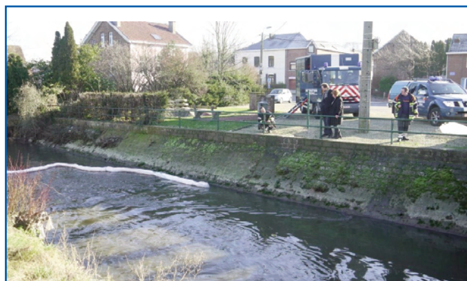
Pose d'un barrage flottant empêchant la dispersion du mazout.
