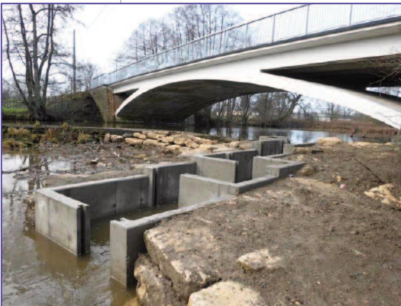
Le débit type de fonctionnement est de l'ordre de 75 litres/seconde. En période de débit important et en période de crue – où il y a submersion du barrage - le passage du poisson se fait naturellement si ses capacités de nage (espèce, taille) le permettent et si la période est propice à la migration.
