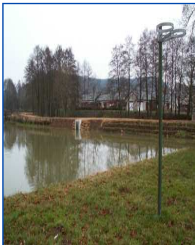
C55 - Réalisation de travaux d'aménagements du lac de Messancy et de ses abords en bassin écrêteur - Commune de Messancy
