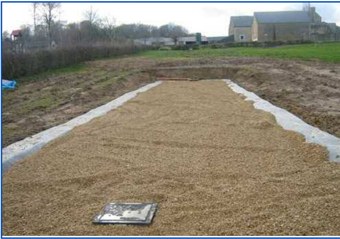
Mise en place d'un système de lagunage permettant le traitement des eaux vertes et blanches de laiterie - Ferme du Chenois.
