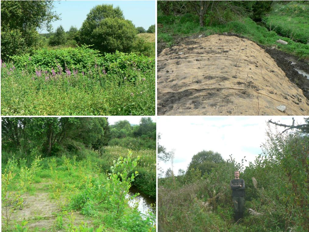
Photos 46 à 49. Evolution d'un site géré par la plantation de plants à racines nues d'*Alnus glutinosa* (S2R2) sur berge talutée et structurée par une natte de coco : état initial (haut gauche), chantier terminé (haut droite), après une saison de végétation (bas gauche) après dégagements de la renouée, après deux saisons de végétation (bas droite).
