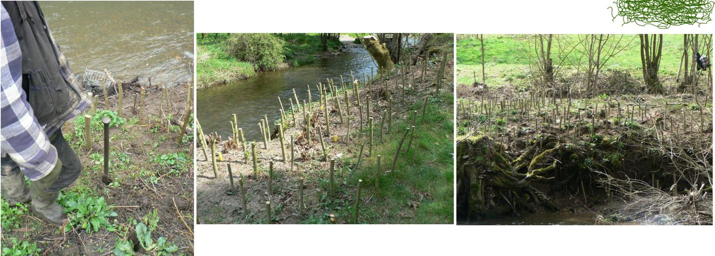
Photos 50, 51 et 52. Plantation de plançons de saules à l'aide d'une barre à mine, selon une densité de 4 - 5 plançons/m<sup>2</sup>
