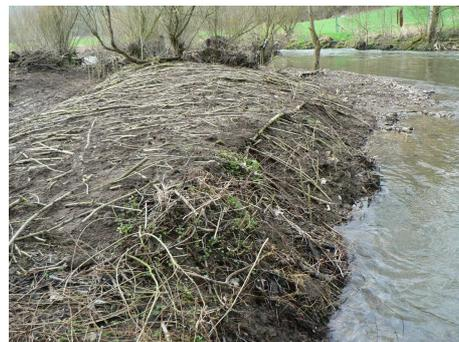
Photo 60. Tapis vivant de saule, réalisé sur berge, après talutage
