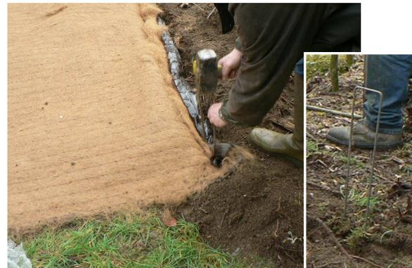
Photos 63 et 64. Positionnement d'une bâche agricole (gauche) ou d'une nappe de paillage (droite). Fixation du pourtour de la bâche dans une tranchée de 15cm de profondeur à l'aide d'agrafes de fixation. Superposition des bandes successives.
