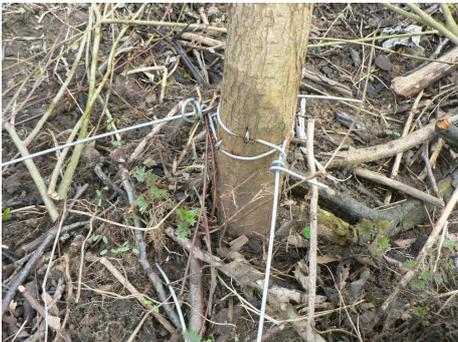
Photo 57. Fixation du fil de fer galvanisé aux piquets
