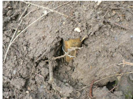
Photo 58. Piquet enfoncé dans le sol pour tendre les fils
